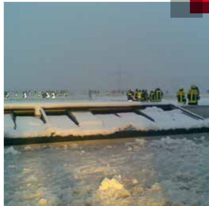
Flachdächer sind extremen Witterungseinflüssen ausgesetzt
