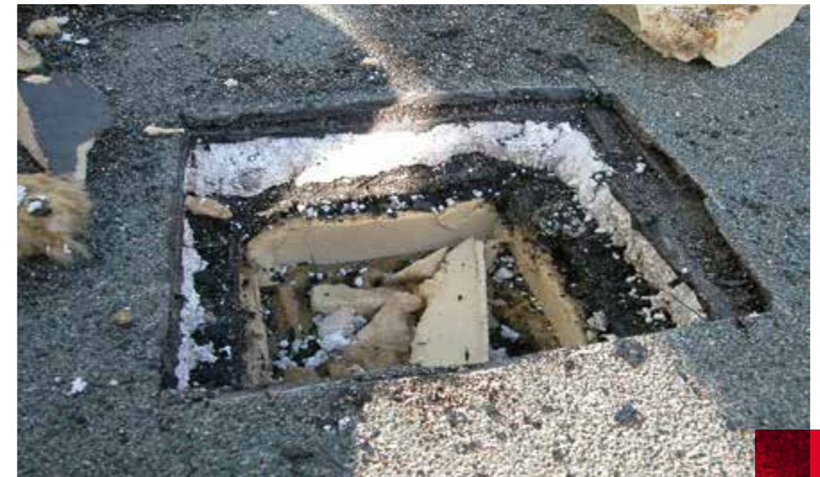
Eine Dachöffnung bringt Gewissheit
