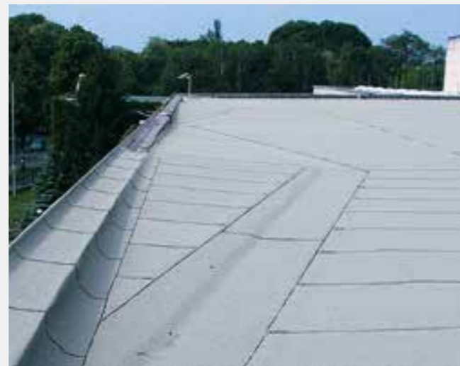
Punktentwässerung entlang der Attika
