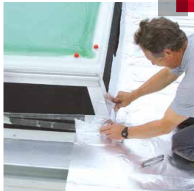
Detailausführung Lichtkuppelanschluss
