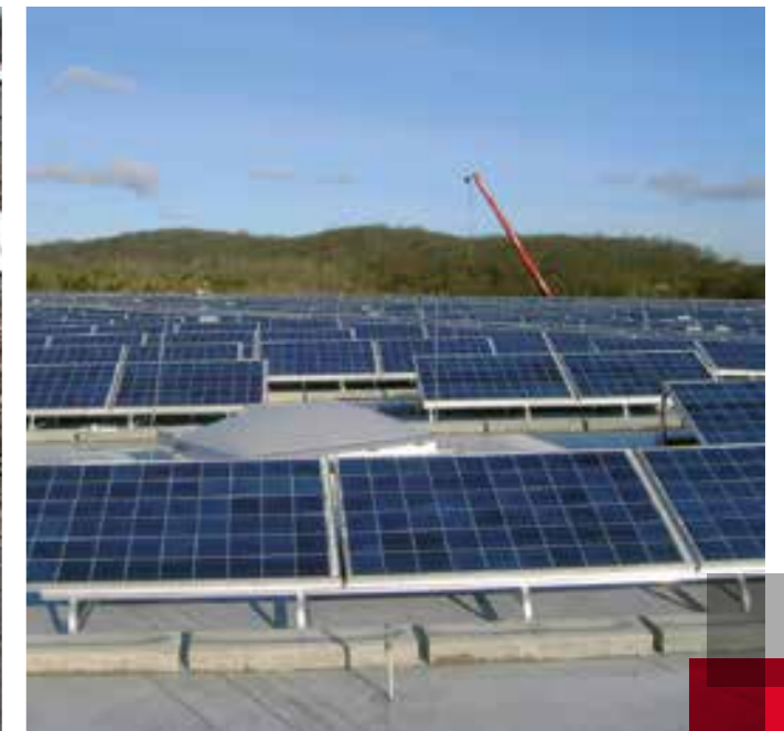
Neue Beanspruchung durch Photovoltaikanlagen
