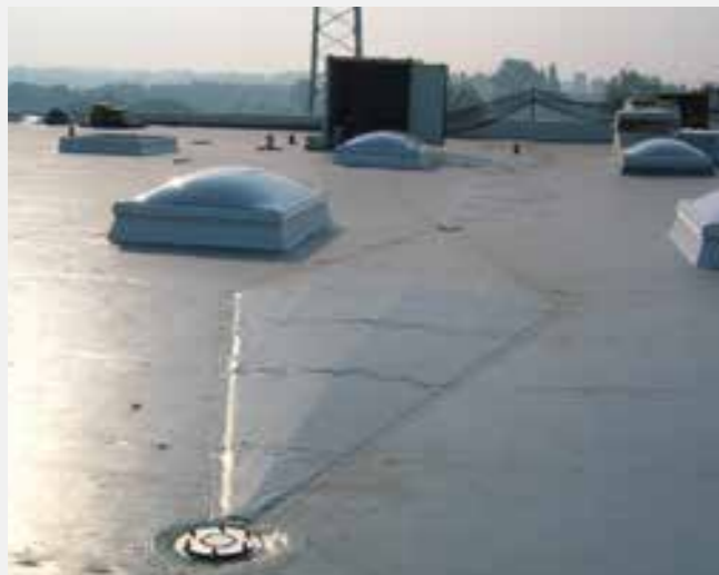
Punktentwässerung entlang der Kehllinien
