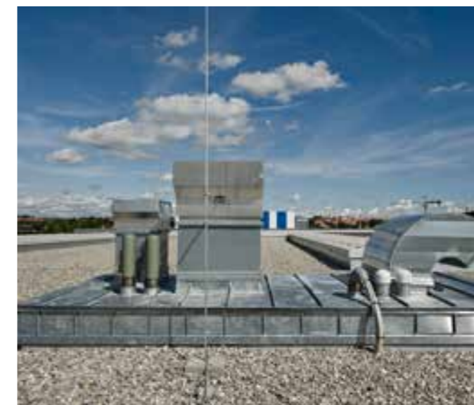
Dachaufbau lose verlegt mit Auflast
