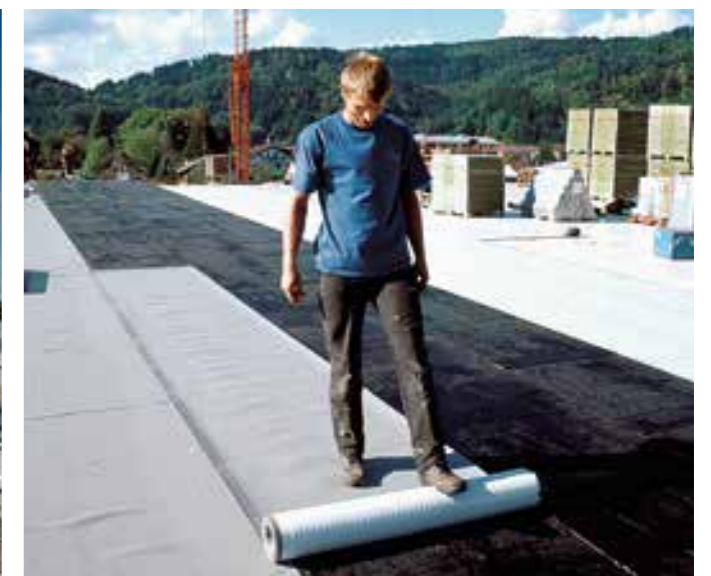
Dachaufbau verklebt
