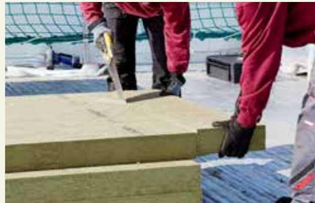
Die Dämmplatten lassen sich leicht zuschneiden.
