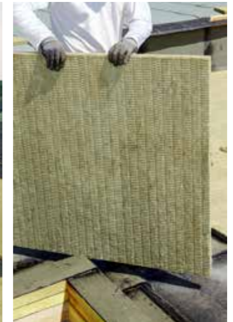
Verlegung der RP-TF auf ausgebessertem altem Dachaufbau
