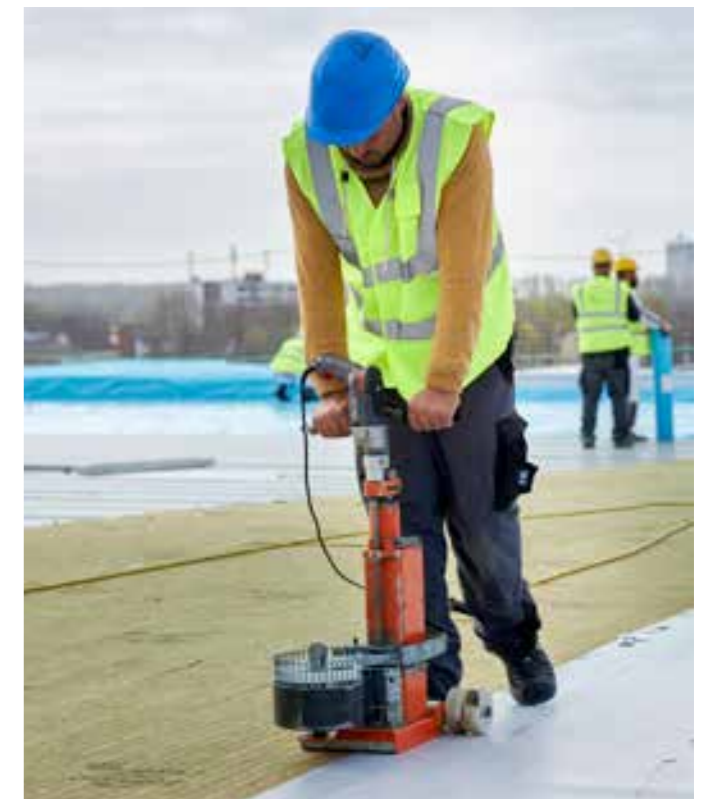
Dachaufbau mechanisch befestigt
