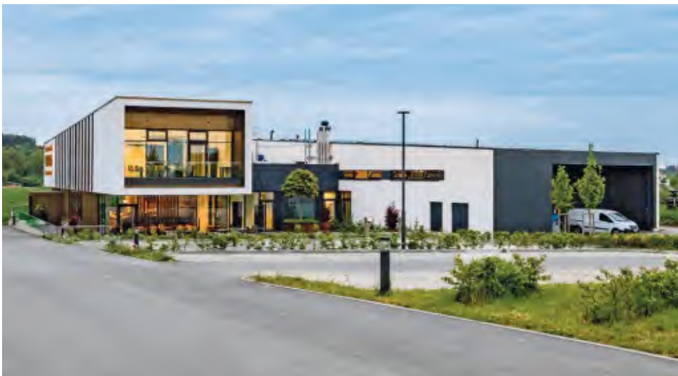
← Das Gebäude gliedert sich in (von links): Café mit Verwal- tung, Zwischenbau und Produktion.
